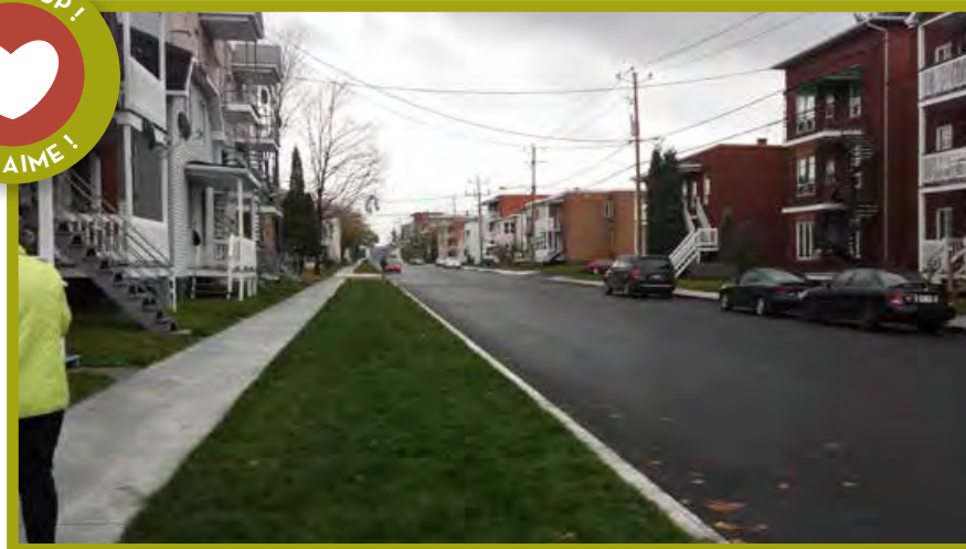
Création d'une bande plantée lors de la réfection routière qui accueillera des arbres, rue Lambert, Shawinigan, 2015.
