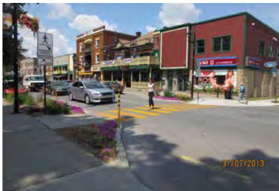
Avancées de trottoir et passage piéton sur la rue Gill, Granby 2013.
