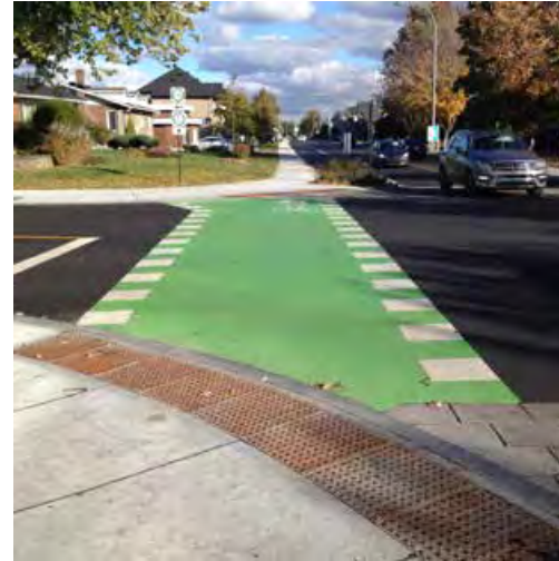
Passage piéton texturé et coloré et surface avertissante sur le bateau pavé, Chemin des Prairies, Brossard, 2015.
