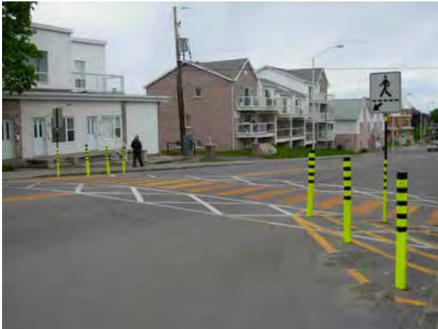
Traverse piétonne à mi-tronçon et marquage à rayures avec bollards, avenue de la Cathédrale, Rimouski, 2015.
