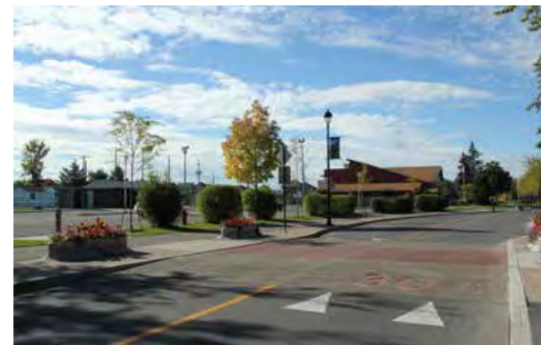
Traverse piétonne surélevée de couleur à mi-tronçon, Candiac, 2013.
