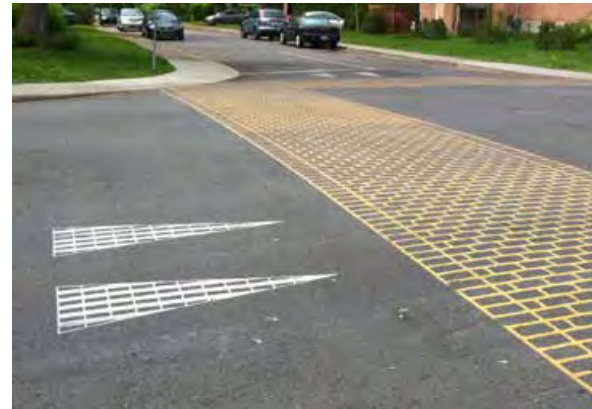
Passage piéton texturé et intersection surélevée, Saint- Lambert, 2013.
